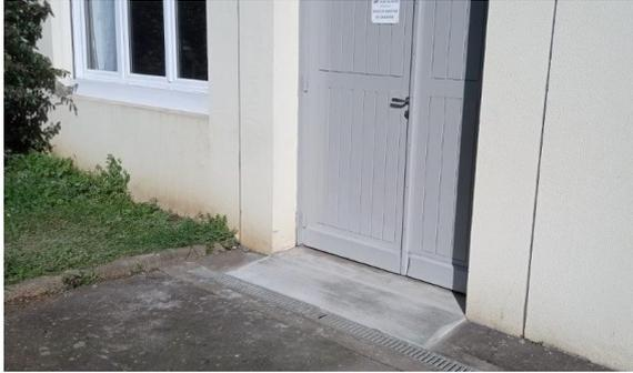
Porte d'entrée repeinte et vue de la petite pente en béton réalisée
